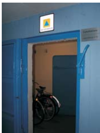
Skyddsrum med väl synlig skylt
