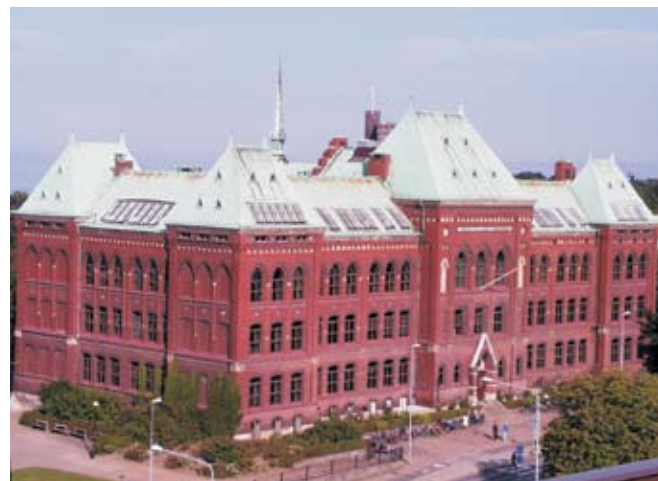
I skolor behövs vädring - fönsterventilation
